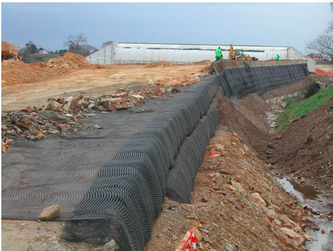
La geomalla de refuerzo debe extenderse “estirada y sin arrugas” y se fijará al suelo utilizando grapas de fijación.
