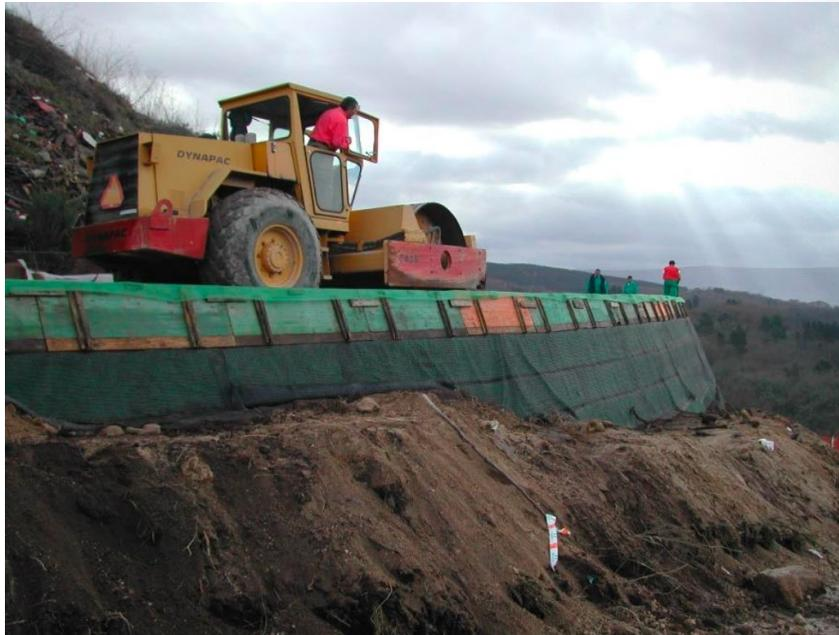
La tongada debe tener una pendiente transversal hacia el trasdós de aproximadamente un 4% para que las aguas superficiales en caso de lluvia sobre una tongada en ejecución, se canalicen hacia el drenaje del trasdós.
