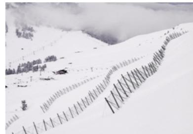
**Estructura de Soporte:** está constituida por perfiles de acero de sección circular, dimensionados para alcanzar la altura útil de interceptación y vincular la red a los elementos de fundación.
